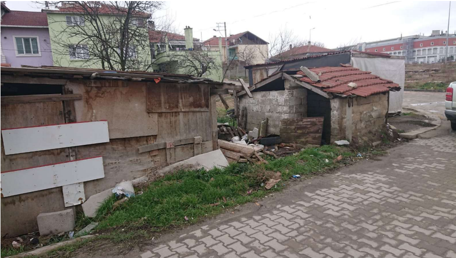
Yeşiltepe Mahallesi 533 ada 7 parselde bulunan metruk yapıya ait resim
