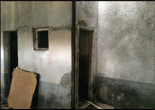
Muhtarlık Binası Tadilatın Önce
