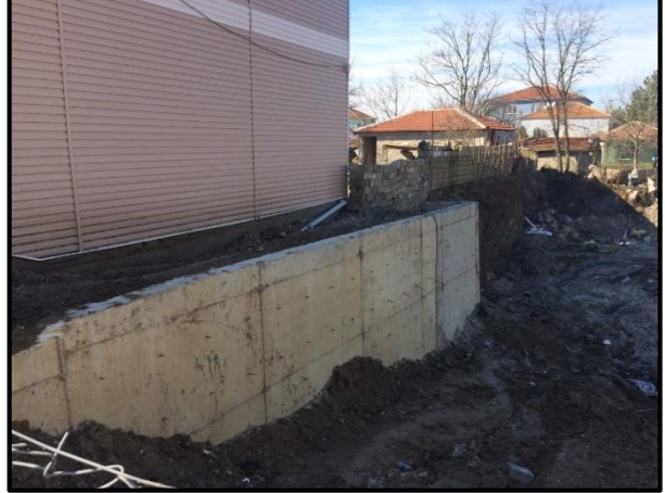
İstinat Duvarı Yapım Çalışmaları
