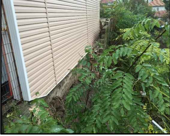
Çalışma Yapılmadan Önceki Durumu
