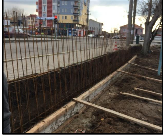
Perde Duvar Yapımı
