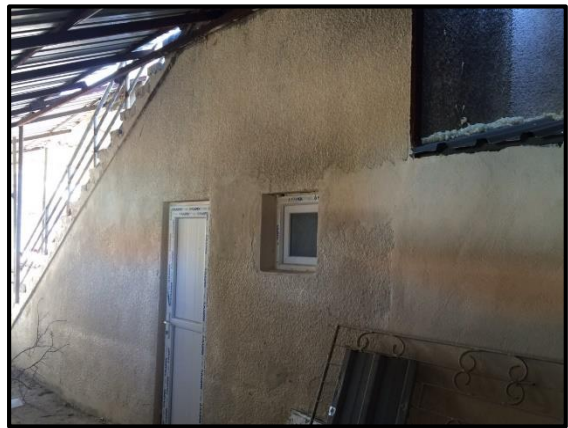
Muhtarlık Binası Tadilatın Sonra
