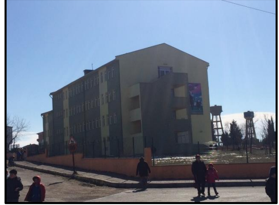
Yangın Merdiveni Tadilattan Sonra
