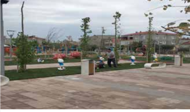
-Şiltepe Muhtarlık Arkası Park'ın inşa edilmesi
