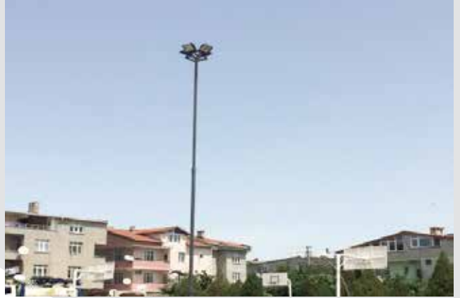
-Deri fabrika arkasına 14m Led Armatürlü Aydınlatma Direği monte edilme
