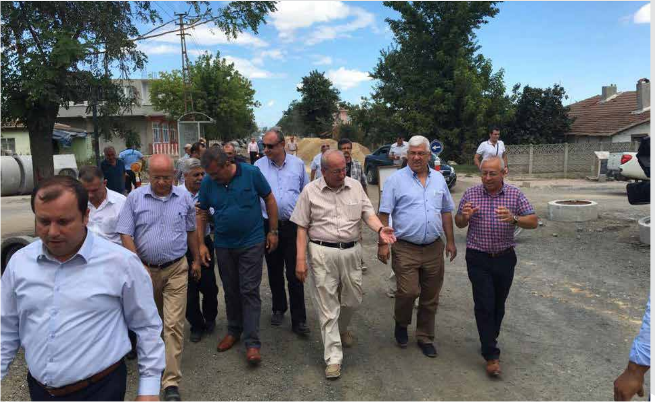
Vakıflar Mahallesi alt yapı çalışmalarının denetlenmesi-Ergene 2016
