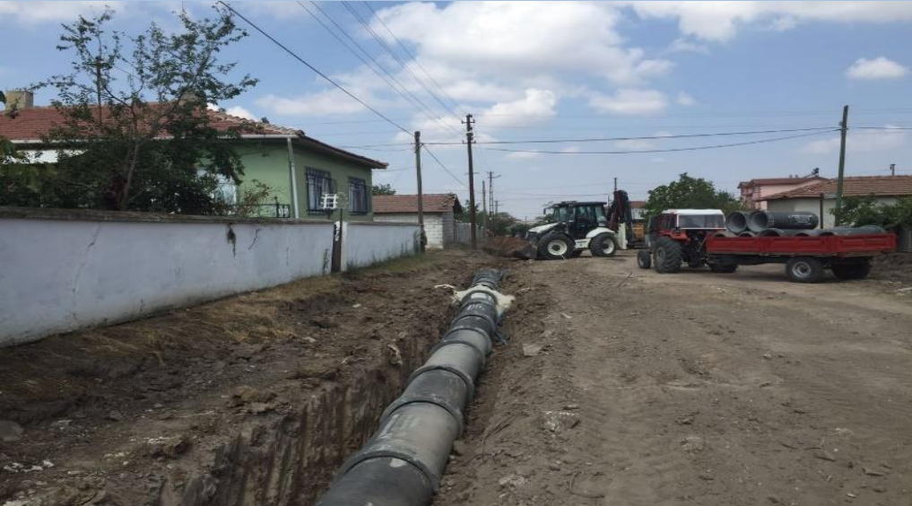
-Yağmur Suyu Hattı ve ızgara yapılması
