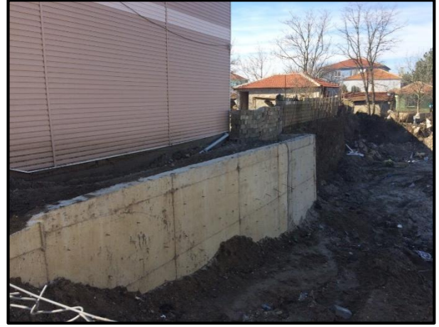
İstinat Duvarı Yapım Çalışmaları
