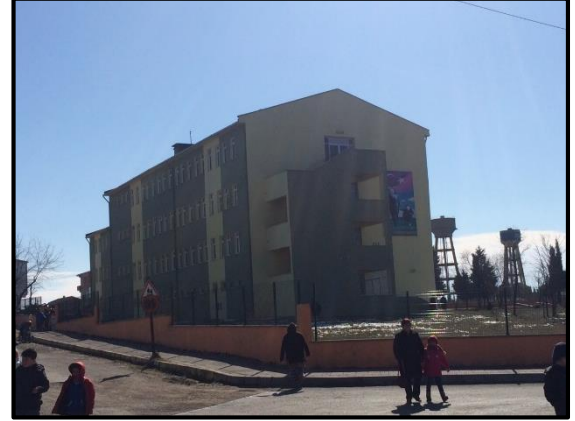
Yangın Merdiveni Tadilattan Sonra
