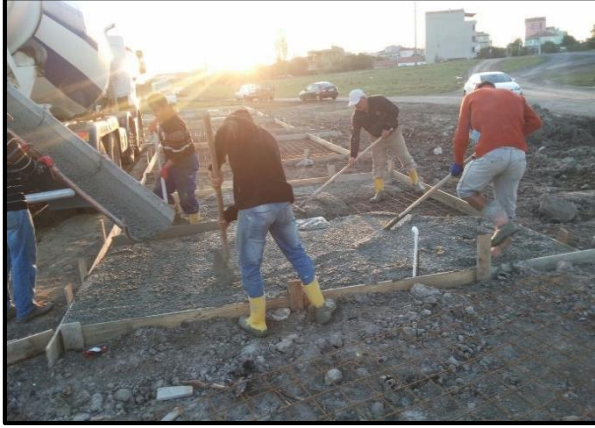
Kurban Kesim Yeri Beton Dökme Çalışmaları
